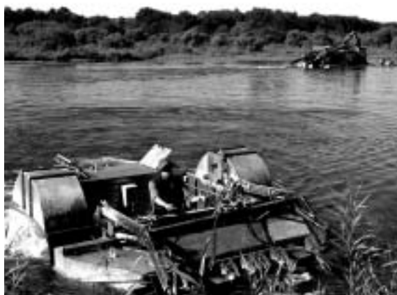
Travaux CG 44/SMN - Canal de Nantes à Brest Photo Région des Pays de la Loire - S. Boudy / D. Wauthier
